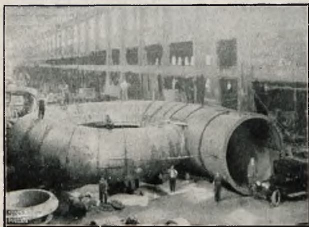
Rys. 7, 8 i 9. Turbiny dla Niagary. HP = 70 000, n = 167 , H=213 stóp. Waga wirujących części przeszło 32 tony.
