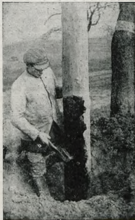
Rys. 16. Smarowanie nasyconego słupa „Kobrolitem”.
