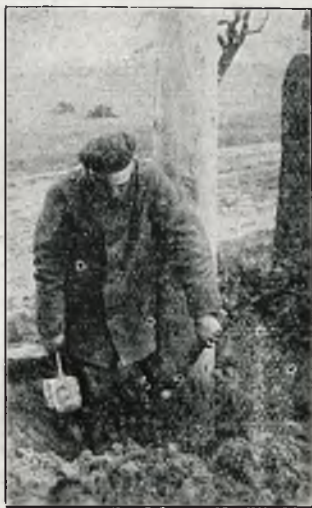
Rys. 15. Nasycanie słupów ustawianych na gruncie.
