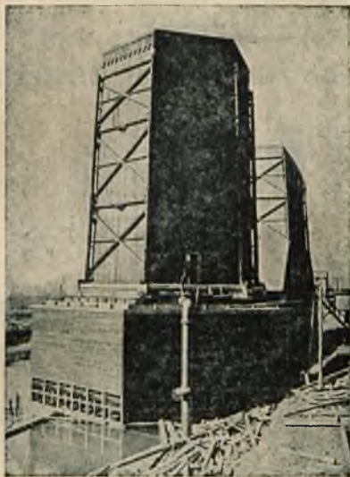
Chłodnica kominowa o prądzie powietrza poprzeczno-zwrotnym, ustawiona w Fabryce Cementu „Wysoka”, w Łazach o wydajności 900 m 3 /godz.
