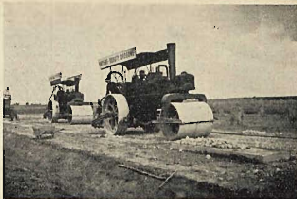
Wykonywanie nawierzchni bitumicznej.
