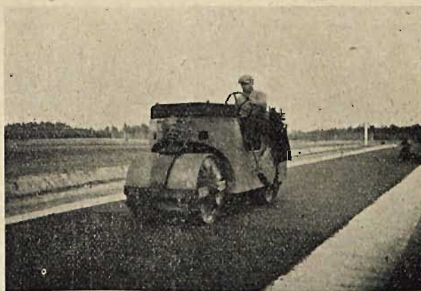
Podbudowa — renowacja szosy tłuczniowej.
