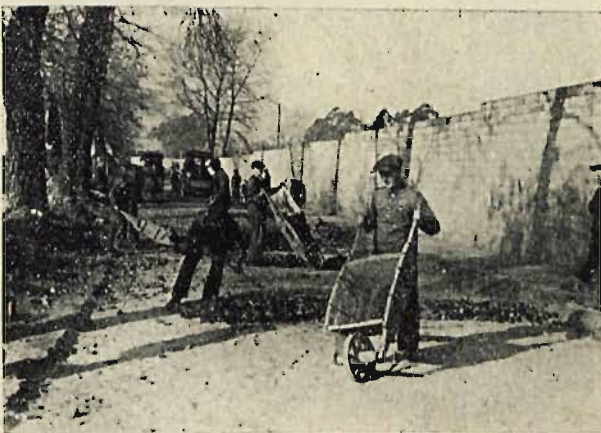
Przygotowanie podłoża: rozścielanie i walowanie szutrówki.
