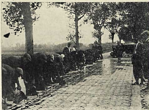
5. Zalewanie spoin asfaltem.
