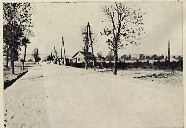
Nawierzchnia betonowa na drodze Cieszyn — Bielsko pod Skoczowem.
