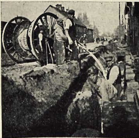
Odwinięcie kabla z bębna
