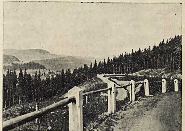
Droga z Wisły do Istebnej naw. powierzchniowo bitumowana.
