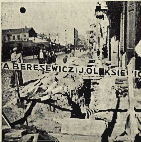
Wykop na trasę kablową
