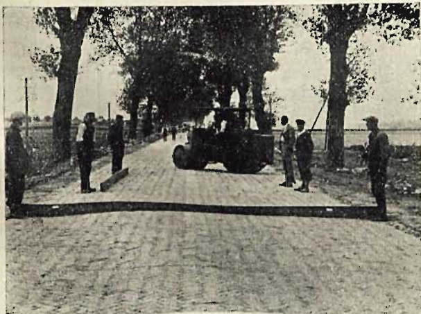
4. Wałowanie klinkieru i sprawdzanie profilu.
