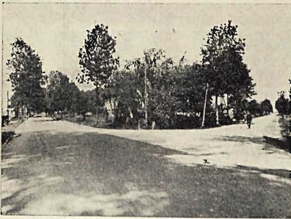
Polączenie nawierzchni makadamowo - cementowej drogi powiatowej Pszczyna — Bieruń z nawierzchnią asfaltobetonową drogi wojewódzkiej Mikołów — Pszczyna.
