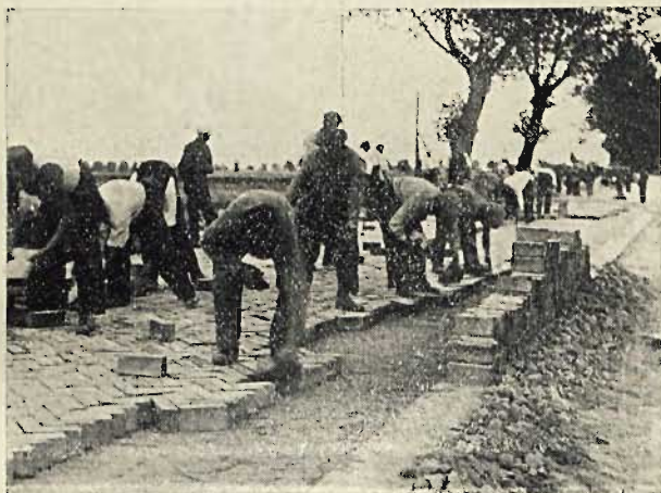
3. Układanie klinkieru.
