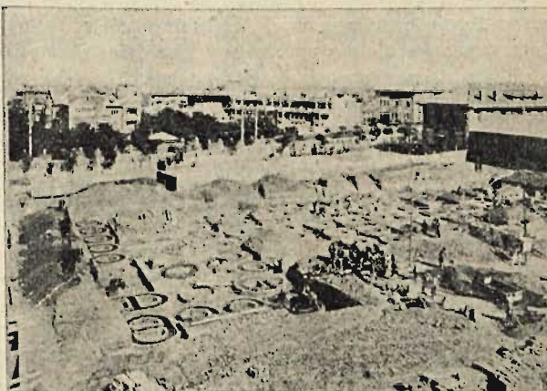
Rys. 2. — Formy z cegiel dla noży studzien.
