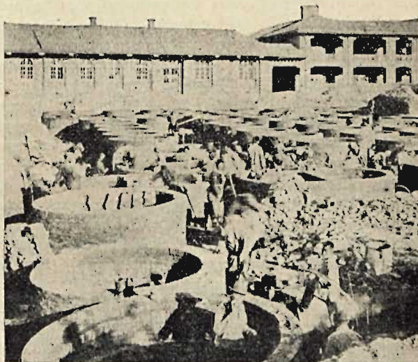
Rys. 1. — Studnie ceglane fundamentów.
