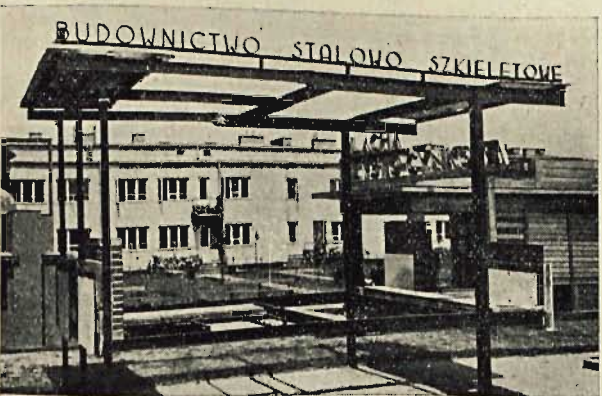
7. Model konstrukcji stalowo-szkieletovej. Wypełnienie ścian.
