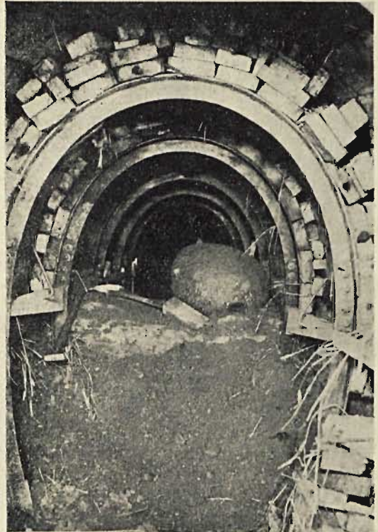
Fot. 1. Moment połączenia („szcink“) dwóch odcinków tunelu na ul. Podleśnej.
