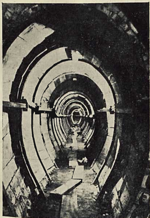
Fot. 3. Odcinek wykończonego tunelu przed przystąpieniem do murowania.
