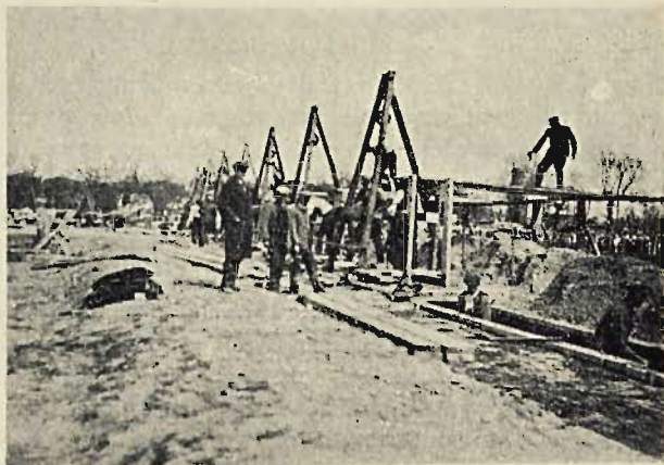
Fot. 5. Wykonanie otwartego wykopu dla kanałów szosowych na Polach Bielańskich.
