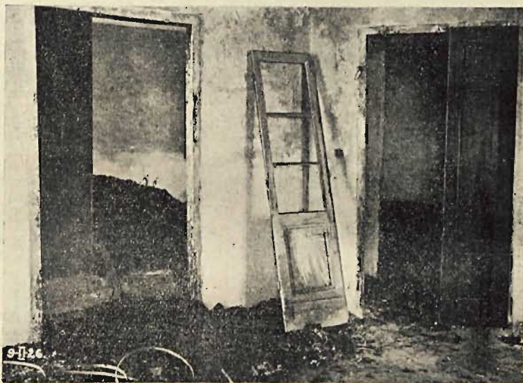
Wnętrze w czasie budowy ma wygląd jakby po przejściu Hunnów.
