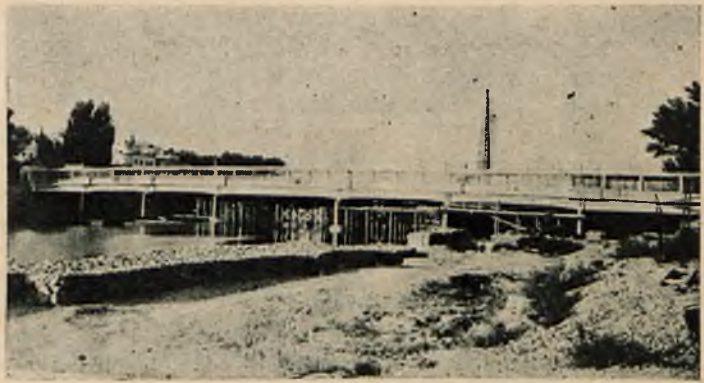
Rys. 9. Żelbetowy most w Pystianach (Czechosl.) wykonany ze stali Isteg.
