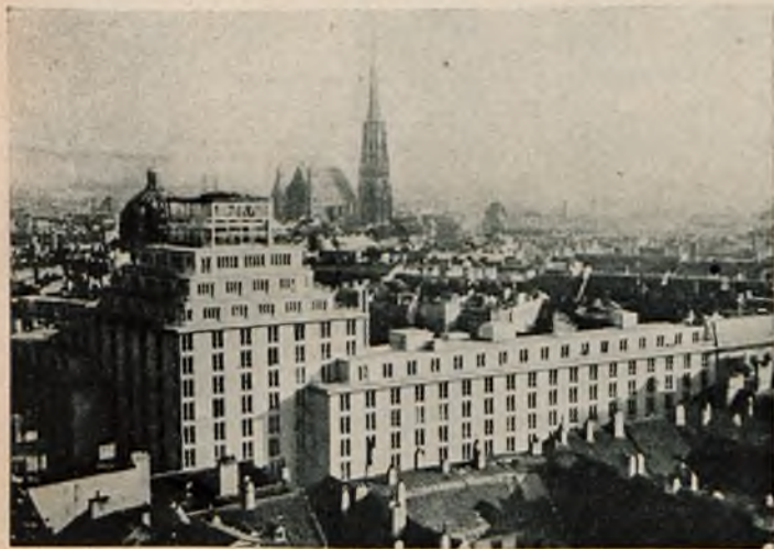
Rys. 8. Budynek żelbet.-szkielet. we Wiedniu wykonany ze stali Isteg.
