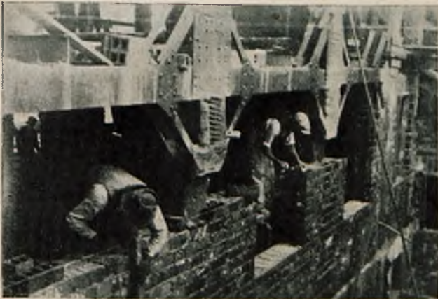
Rys. 5. Wypełnianie ścian zewnętrznych.
