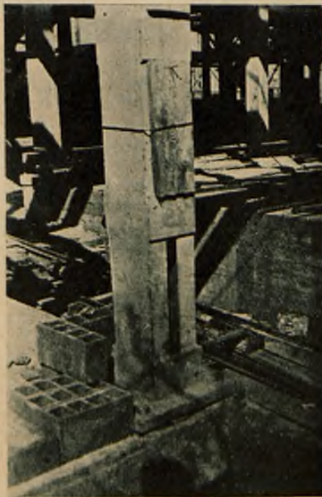
Rys. 4. Obmurowanie słupa.
