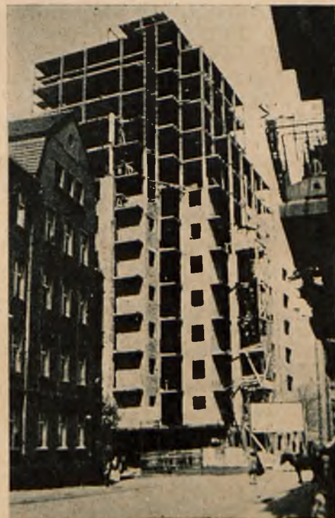
Rys. 8. Wypełnianie szkieletu niosącego.
