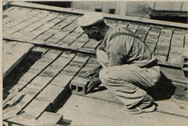
Rys. 6. Wykonanie stropu.
