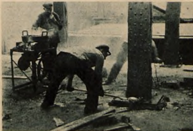
Rys. 3. Zalewanie stopy fundamentowej słupa.
