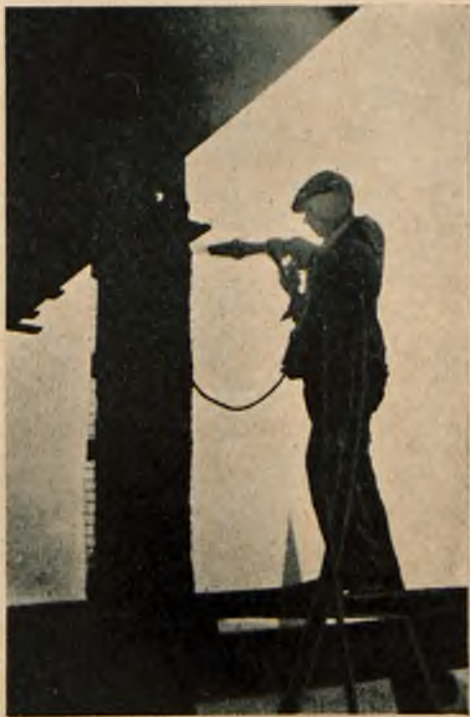
Rys. 7. Torkretowanie słupa.
