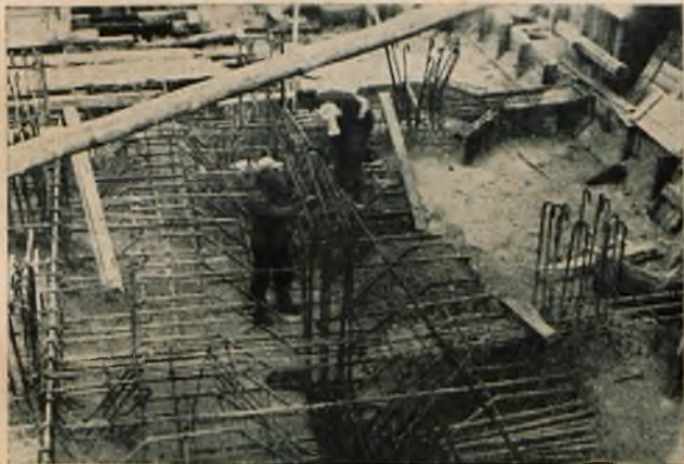
Rys. 1. Fundamenty żelbetowe pod konstrukcję stalowo-szkieletową.
