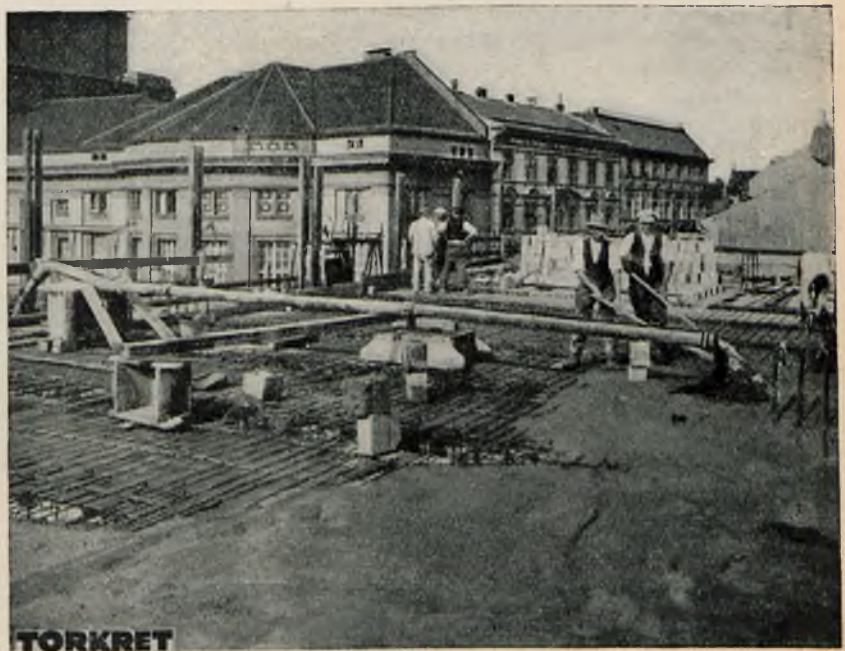
Rys. 4. Wyjście betonu z rury 12-o centymetrowej.
