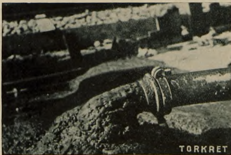
Rys. 2. Wyjście betonu, stosunek zmieszania 1 : 5, około 60% kruszywa od 7 — 50 mm., wydajność okrągło 14 m 3 /godz.
