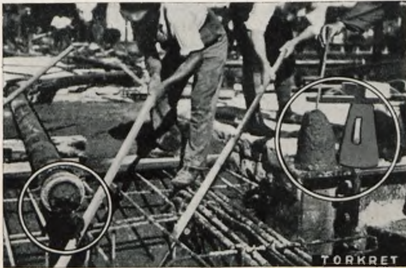
Rys. 3. Wyjście betonu na budowie Ladenburg. Na prawo przeprowadzanie próby osiadania, stożek 30 cm., opadnięcie 5 cm.
