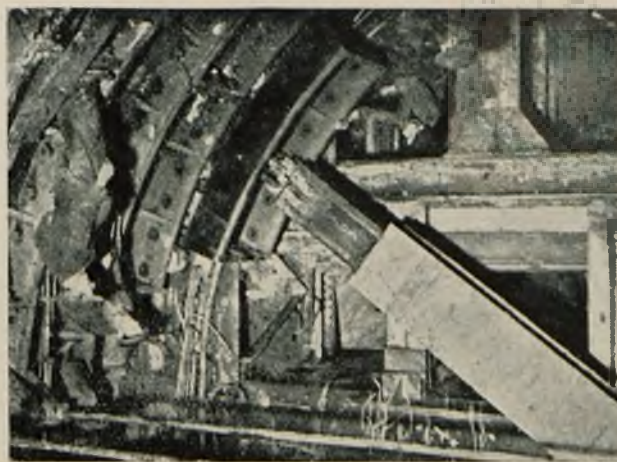
Rys. 7. Osadzenie segmentów żeliwnych przy pomocy ramienia teleskopowego.
