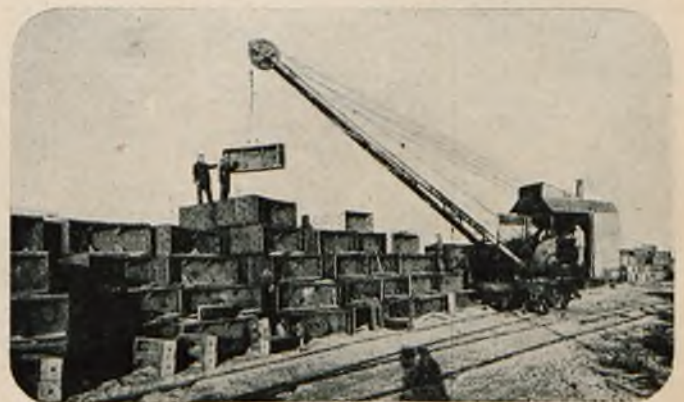
Rys. 4. Widok miejsca składowego segmentów żeliwnych dla szalowania tunelu.
