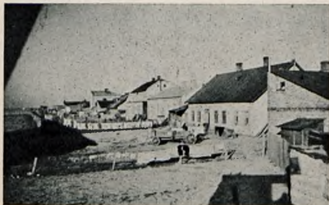
Rys. 3a. Okęcie — Granica działek przechodzi w odł. 3—4 m. od budynków.
