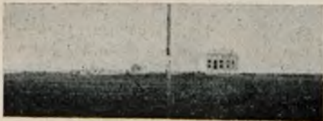
Rys. 18. Służewiec. — Trzypiętrowa kamienica ze ślepymi szczytami w szczyrem polu. Budowa 1932 r.
