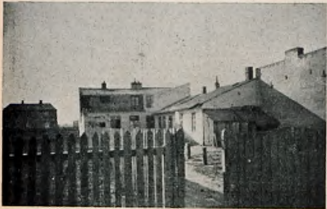
Rys. 13. Okęcie. — Oficynowa obudowa podwórza. Osiedle powojenne.
