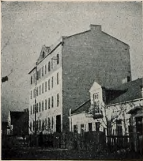
Rys. 17. Włochy. — „Drapacz chmur” wśród parterowych domków. Osiedle nieskanalizowane. Budowa 1933 r.
