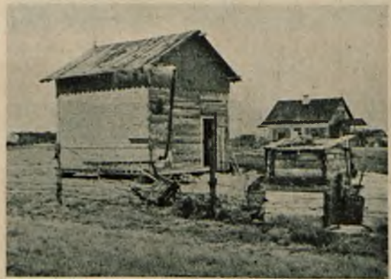
Rys. 9. Otwock — dzielnica Kresy. — Budynek zbudowany bez zatwierdzenia w ciągu dwóch dni. Zabudowa powojenna.
