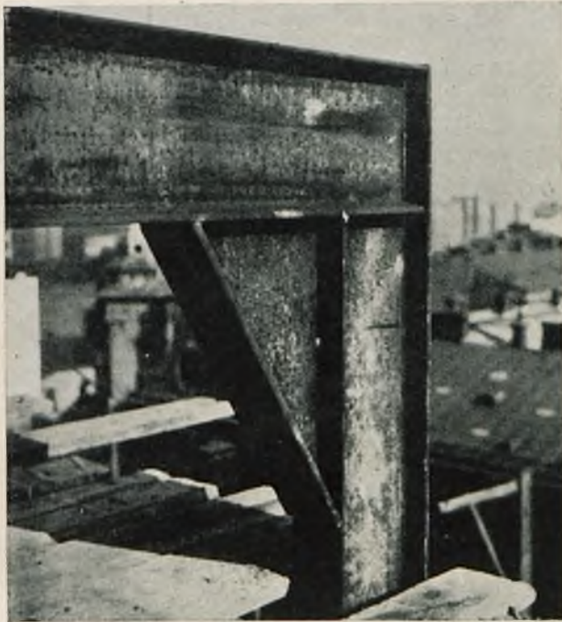
Rys. 6. Ramownica nadbudowy. Wzrost narożny ramownicy ze słupem zwykłym.
