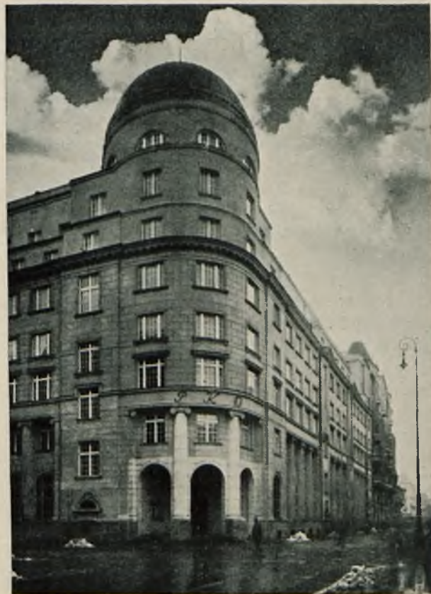
Rys. 2. Widok zewnętrzny gmachu P. K. O. po rozbudowie. Fasada wykonana w Terrazycie.
