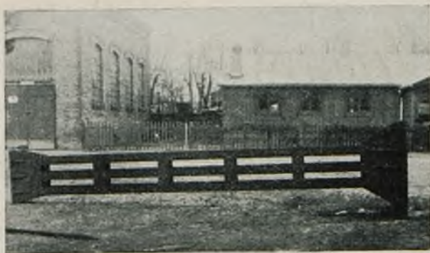
Rys. 15. Kolumna suterren wys. 5,90. Widoczny monolityczny charakter słupa.
