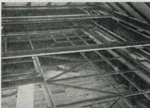
Rys. 11. Fragment podwieszenia dla witrażu przy dachu nad nową salą kasową.
