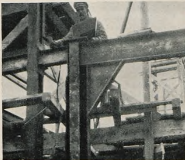
Rys. 5. Kolumna krzyżowa ramownicy po ustawieniu.
