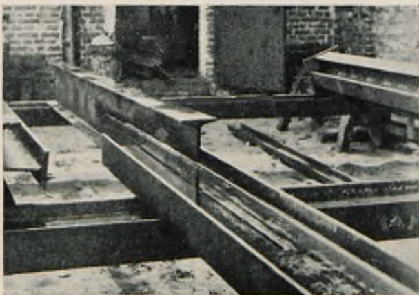
Rys. 3. Kolumna krzyżowa przed złożeniem do spawania.
