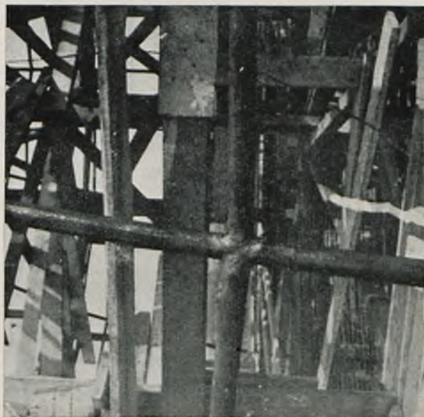
Rys. 13. Normalny węzeł kopuły.
