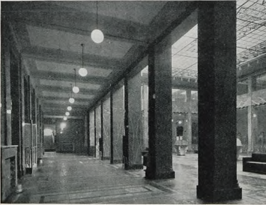
Rys. 4. Kuluar łączący nową salę kasową z salą starą.
