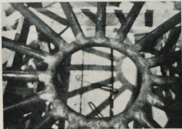
Rys. 14. Pierścień górny kopuły, do którego zbiegają się wszystkie żebra.
