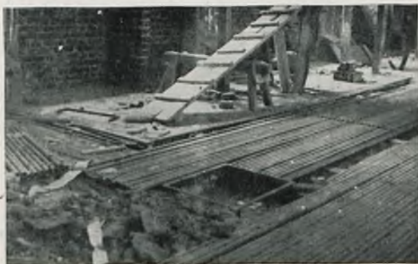
Rys. 2. Fragment układu rur żelaznych w podłodze nowej sali kasowej.
