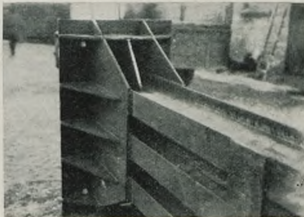
Rys. 16. Typ podstawy kolumny o dużym obciążeniu.
