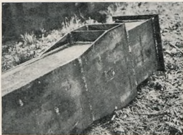
Rys. 1. Głowica kolumny skrzynkowej.
