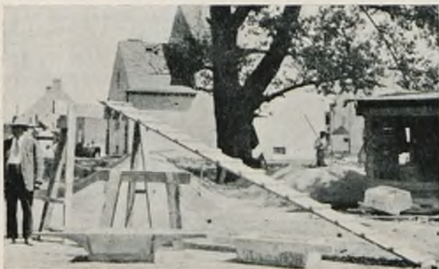
Rys. 2. Sprzęt rusztowaniowy i tragarzy zaprawy, przy sposobie pracy starym.
