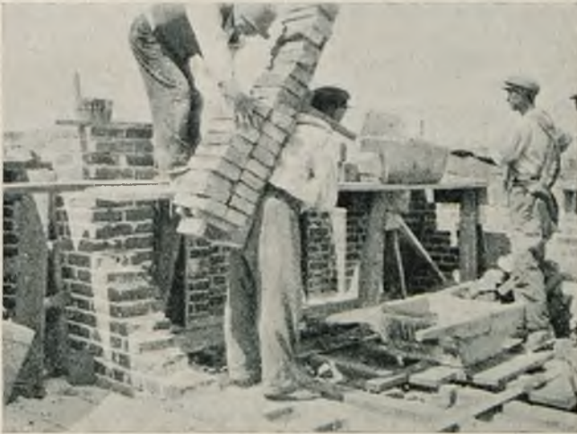
Rys. 5. Stary system pracy koźlarza.
