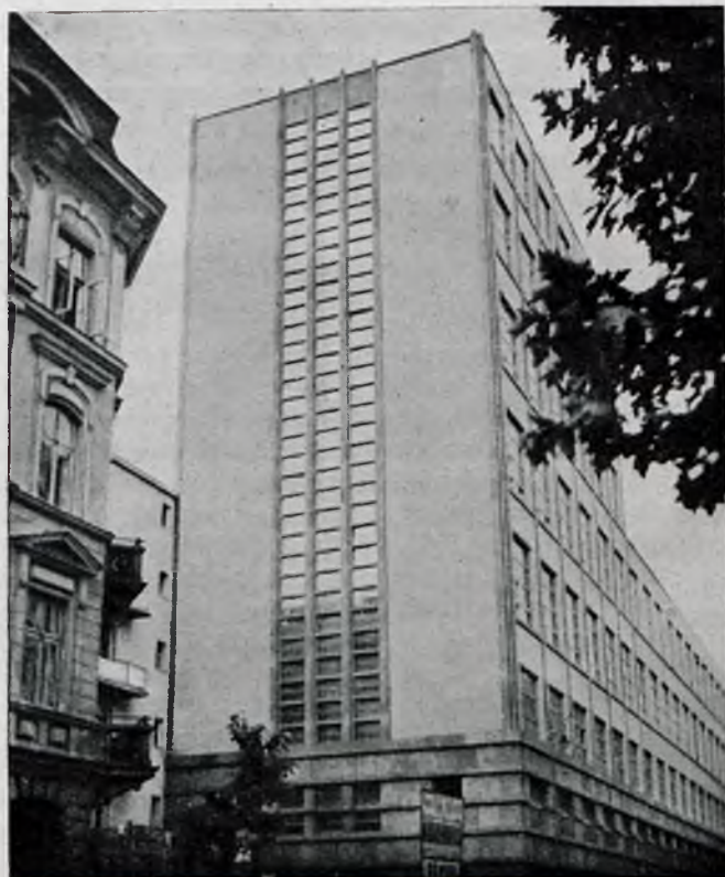
Fasada szczytowa gmachu u zbiegu ul. Poznańskiej i św. Barbary. Wyprawę terrazytową wykonała f-ma „Terrazyt”. Szklenie wykonane przez f-mę Szulc.
