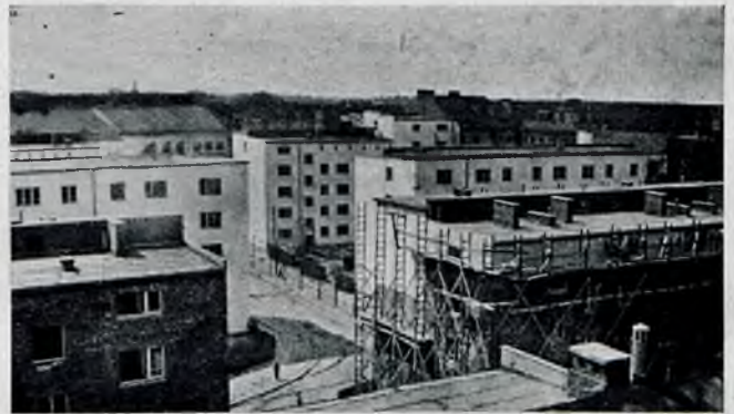
Ogólny widok w okresie robót wykończonych. Lato 1932 r. Izolację dachów Lignoasfaltem i pokrycie Bituminą wykonała firma „Orlorog” w Warszawie.
