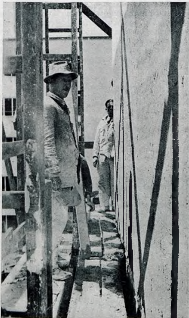
Na rusztowaniu przy tynkach zewnętrznych. Drabiny odsunięte od muru, pomosty do pracy poszerzone.
