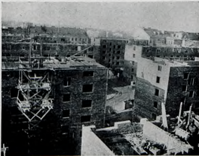
Ogólny widok w okresie robót murarskich. Jesień 1931 r.
