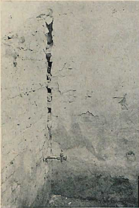
Rys. 2. Widok gazociągu ulicznego w narożu „A”.
