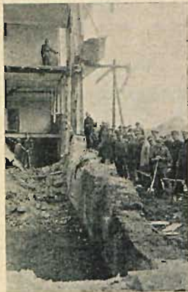
Rys. 6. Widok ściany przy E.
