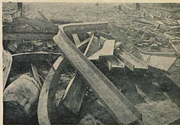
Rys. 8. Złożone na placu belki stropu nadpiwnicznego.
