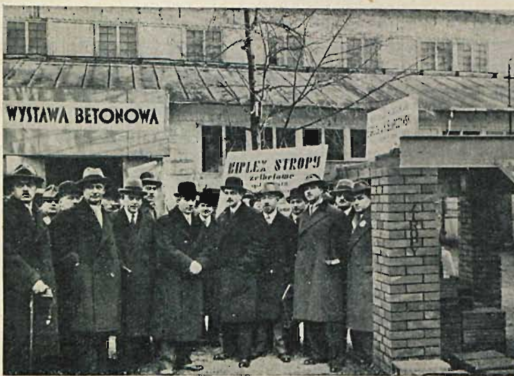
Min. Neugebauer na otwarciu wystawy Betonowej.
