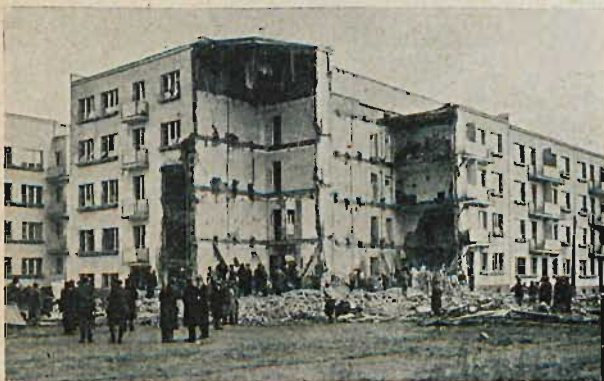
Rys. 3. Widok ściany A B D E.
