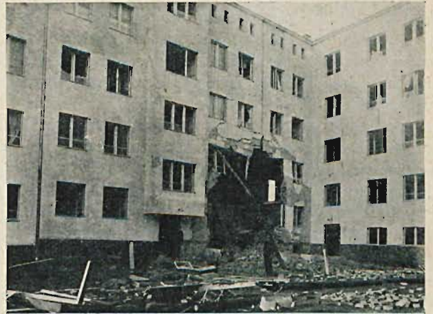
Rys. 5. Widok ściany F G.
