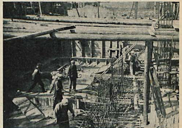
Betonowanie płyty fundamentowej.
