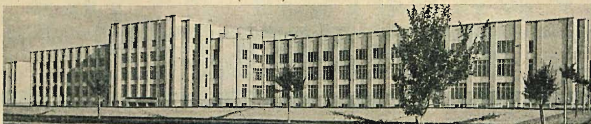
Gmach Polskiej Wytw. Papierów Wartościowych (proj. arch. Dygata) kryty i izolowany Bitumina i Aquisolem.
