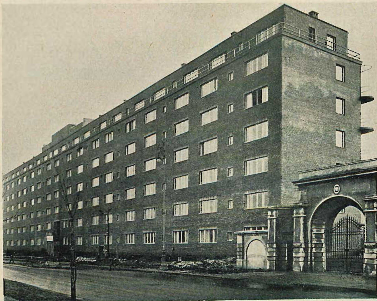
Budowa domu mieszkalnego dla oficerów w Warszawie, ul. Koszykowa 79, Funduszu Kwaterunku Wojskowego.
