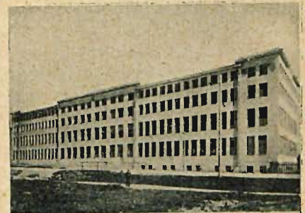
Machorzarnia Państwowej Fabryki Wyrobów Tytoniowych w Grodnie, wykonana przez Towarzystwo Budowlane Inżynierowie K. Stronczyński, R. Czarnota-Bojarski i S-ka S. A.
