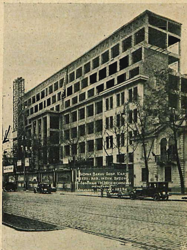
Budowa od strony Al. Jerozolimskich.
