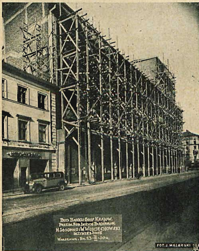
Budowa B. G. K. od strony Nowego Świata.
