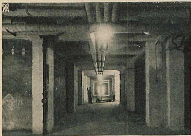
Korytarz między komorami. Okno z cegiełek szklanych.
