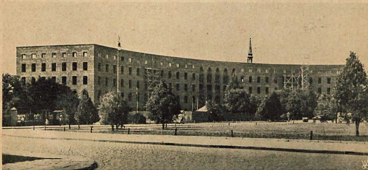
Budowa domu administracyjnego Szpitala Przemienienia Pańskiego na Pradze projekt inż. arch. J. Holewińskiego.
