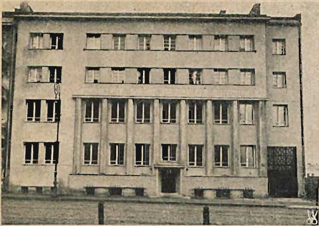
Gmach Powszechnego Zakładu Ubezpieczeń Wzajemnych w Tarnowie wyk. przez Biuro bud. Fr. Skąpski i S-ka.
