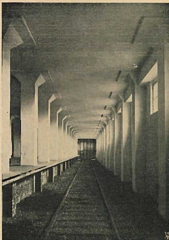
Hall wyładunkowy od strony morza.
