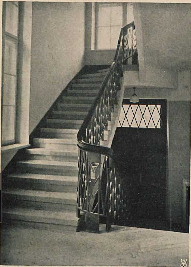
Klatka schodowa boczna.
