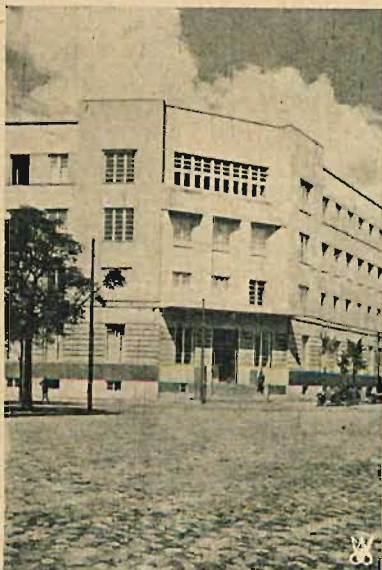
Gmach Dyrekcji Wodociągów i Kanalizacji przy ul. Starynkiewicza. Krycie dachu wykonane przez firmę „GUDRONIT”.
