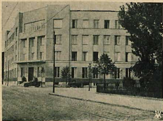
Fasada gmachu wodociągów i kanalizacji.
