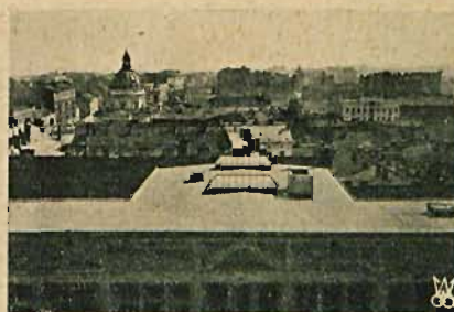
Dach gmachu B. G. K. w Warszawie kryty „Trocalem”.
