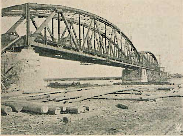
Demontaż w Opaleniu.
