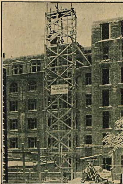
Budowa Gmachu Spółdzielni w Warszawie, Al. Ujazdowskie 9.
