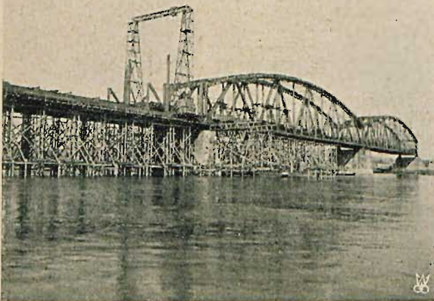
Demontaż w Opaleniu.
