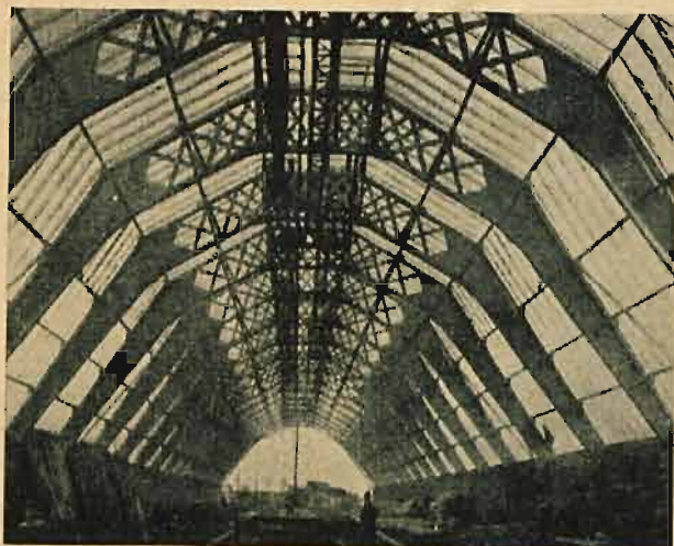
Skład soli potasowej w Ołomuńcu, konstrukcja ramowa 22 m. rozp. 150 m. dług.
