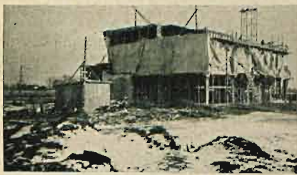
Ogólny widok tej samej budowy.
