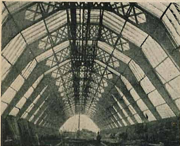
Skład soli potasowej w Ołomuńcu, konstrukcja ramowa 22 m. rozpięt. 150 m. dług.
