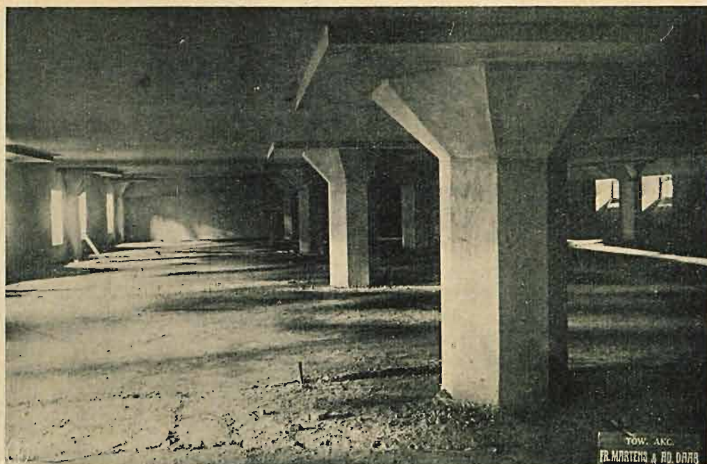
Fig. 10. Budowa gmachu P. Z. U. W. w Warszawie
