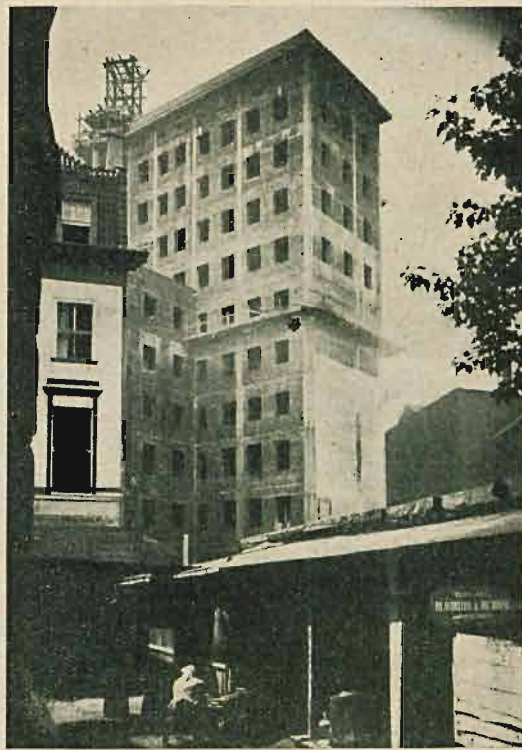
Fig. 8. Budowa gmachu P. Z. U. W. w Warszawie.
