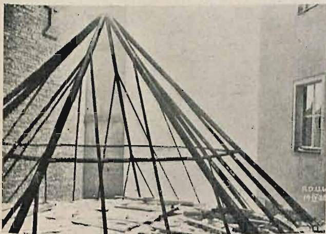
Fig. 1. Konstrukcja świetlika okrągłego.
