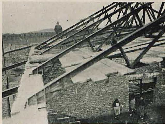
Fig. 4. Podporowe części więzarów dachu w Skarżysku.
