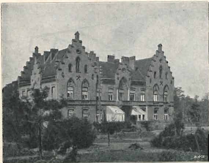
Rys. 16. Widok domu w Żąbkowicach. Arch. Cz. Domaniewski.
