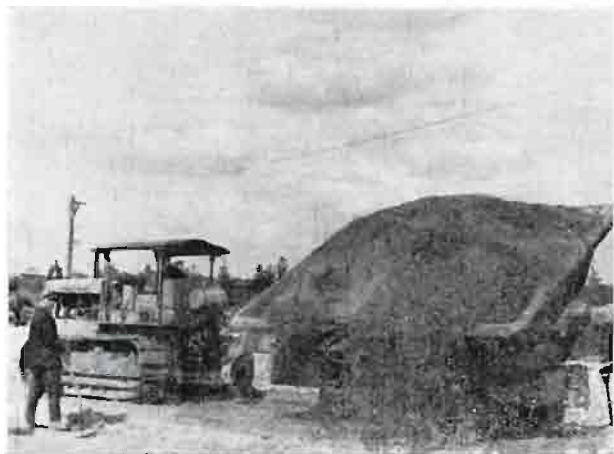
Rys. 16. Dowóz materiału ziemnego na tamę.
