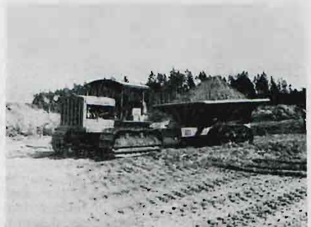
Rys. 15. Transport materiału ziemnego do budowy tamy.
