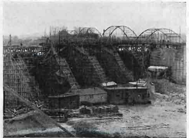
Rys. 6. Filary na wlocie do zakładu.
