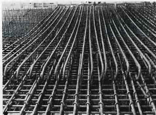
Rys. 11. Zbrojenie żelbetowego dachu zakładu wodnego.
