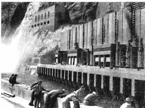
Rys. 34. Widok na prawobrzeżną część zakładu wodnego.
