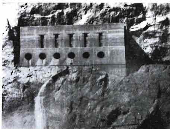
Rys. 33. Budynek zamknięć wypustów prawobrzeżnych.
