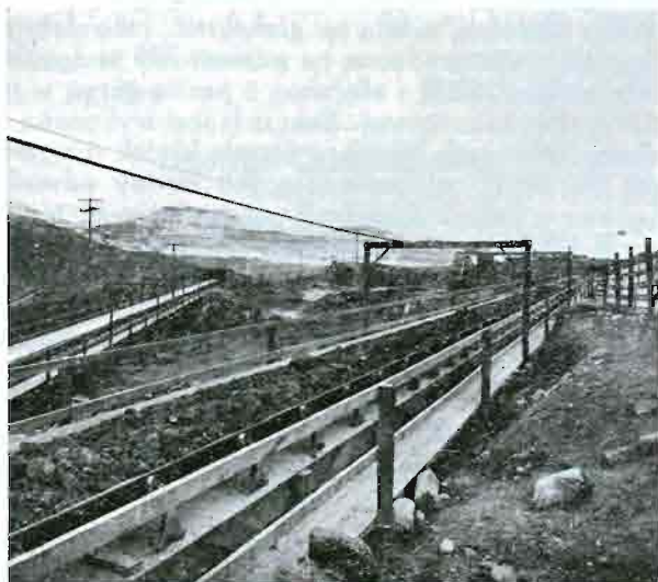
Rys. 18. Transporter taśmowy.
