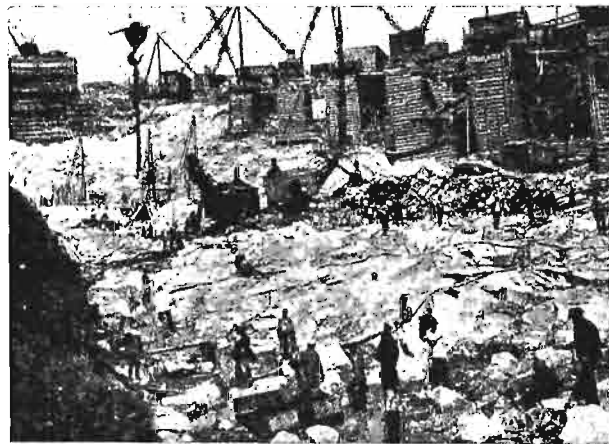
Rys. 15. Roboty ziemne w partii środkowej.
