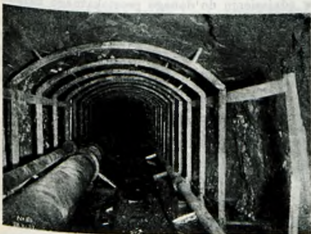
Rys. 14. Wnętrze sztolni z przewodami i rusztem pod blachy szalujące.
