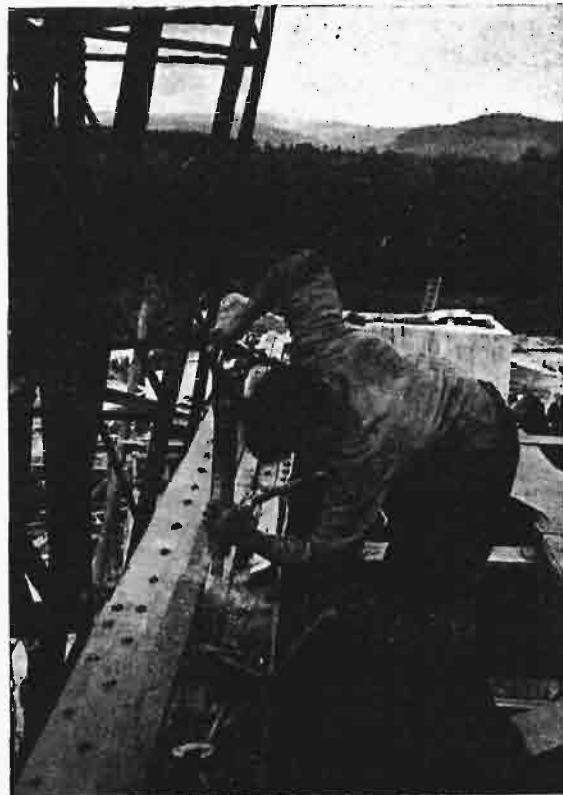
Ryc. 15. Nitowanie konstrukcji żelaznych przy pomocy młota pneumatycznego.
