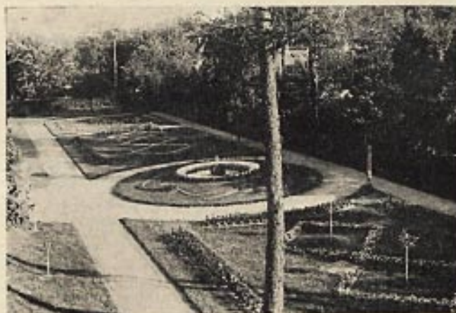
wie ln kl przy peronie dworca st. Kłwerce.
