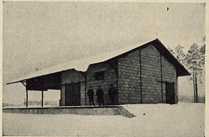
Rys. 5. Magazyn towarowy ze ścianami z pustaków.
