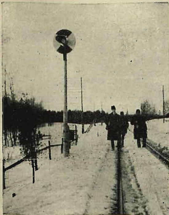
Rys. 3. Semafor ostrzegawczy kolei szwedzkich ze światłem błyskowym.
