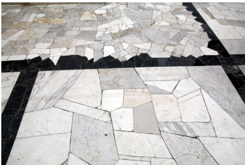
Bardzo udana kompozycja posadzki Dużej Auli z potłuczonego marmuru wg projektu inż. arch. Cz. Duchnowskiego
