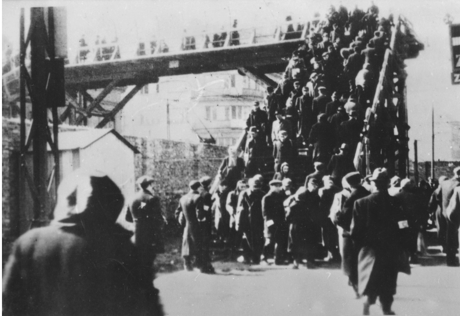
Estakada wykonana na skrzyżowaniu Chłodnej i Zielnej. Umożliwiła pieszym komunikację między gettem dużym i małym. (zb. NAC)
