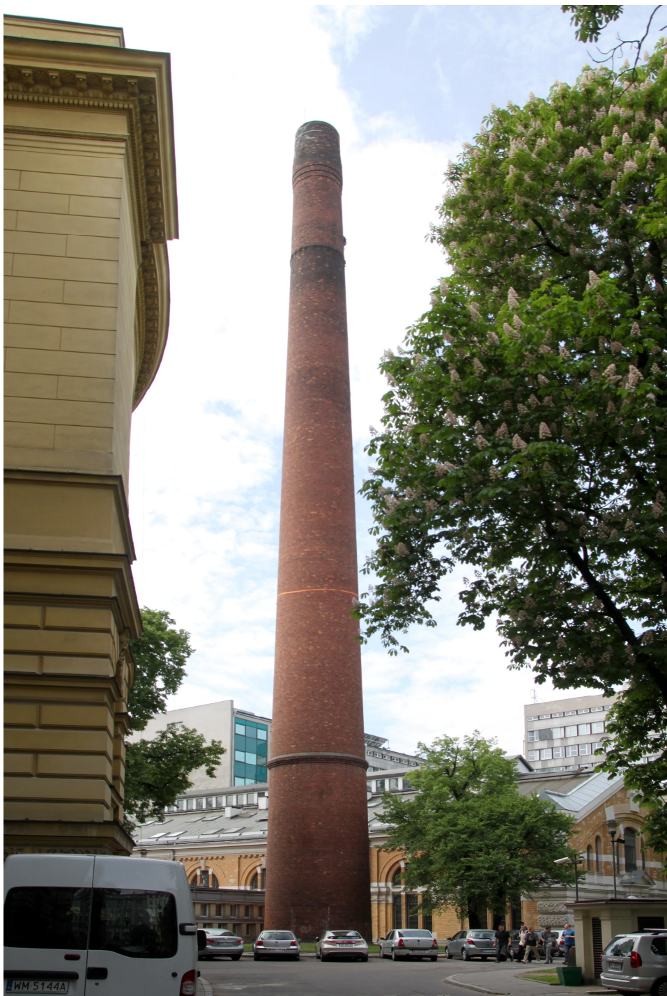
Komin, dominująca budowla na Terenie Głównym Politechniki
