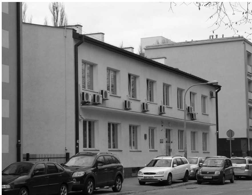
Budynek przy ul. Sokołowskiej naprzeciw kościoła św. Stanisława. Siedziba Gestapo podczas masowych mordów mieszkańców Woli w czasie Powstania. W nim przetrzymywano Verbrennungskomando.
