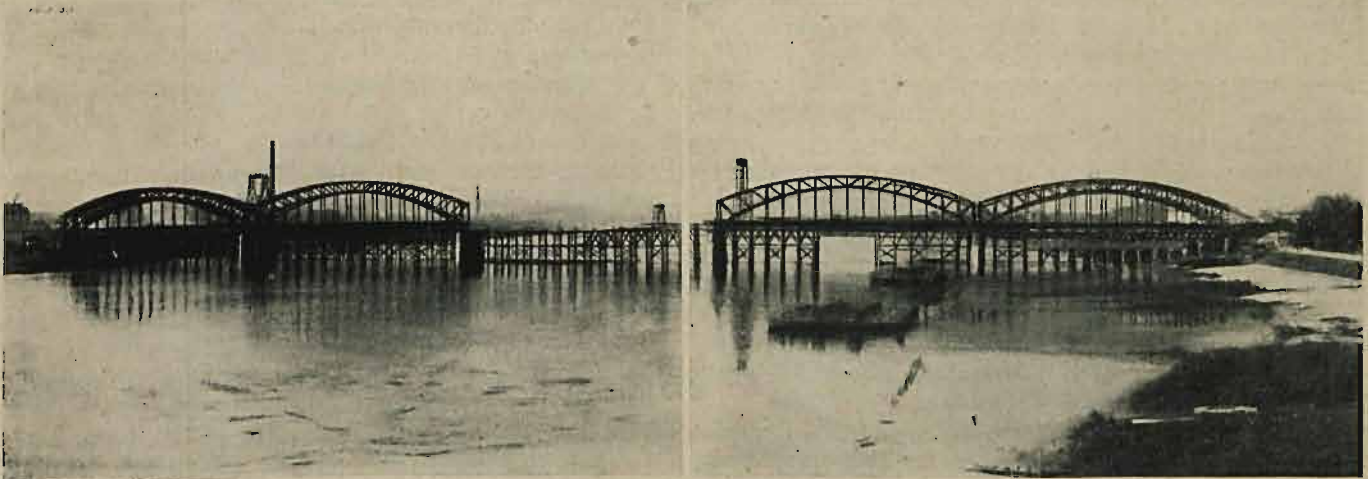
Ogólny widok montażu mostu linii średnicowej w Warszawie na Wisłę
