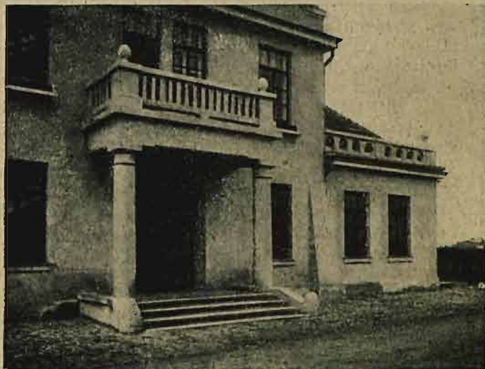
Fragment dworca Sławków od strony podjazdu
