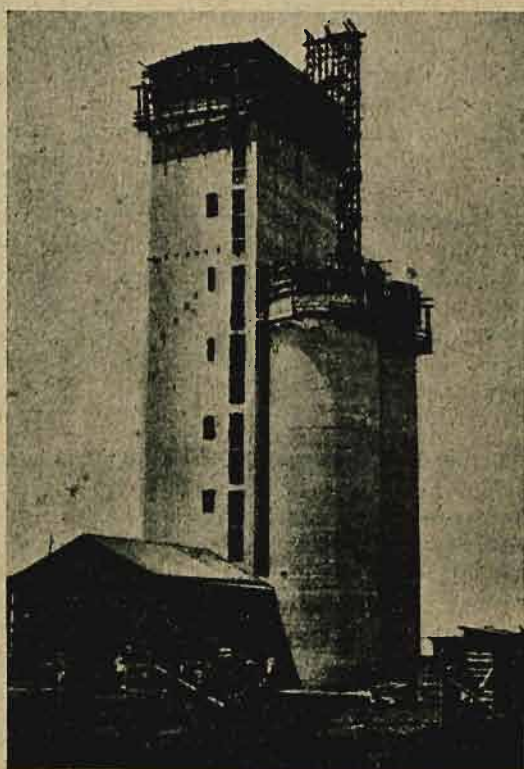
40 m. wysoki żel-betonowy elewator, zbudowany w przeciągu 19 dni
