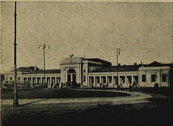
Rys. 8. Dworzec Zachodni w Poznaniu.
