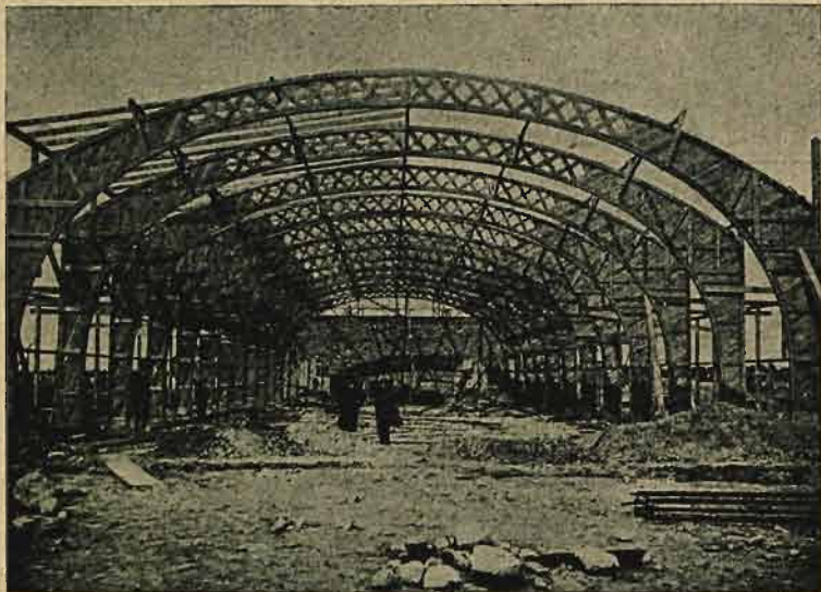
Budowa Pawilonu Przemysłu Spożywczego.
