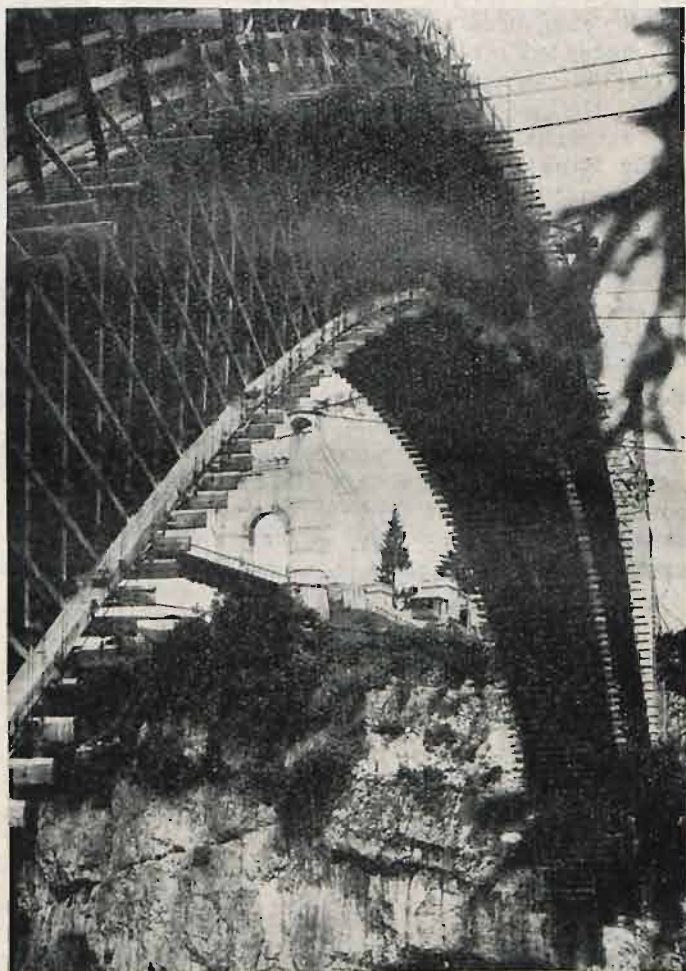
Ryc. 11. Wykończony łuk krążynowy. Wgłębi stary most wiszący.
