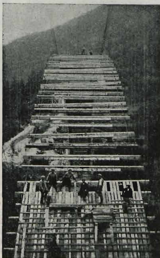
Ryc. 7. Wykonanie kładki, zawieszonej na kablach.
