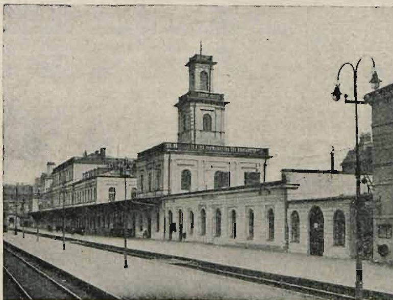
Warszawa Gł. Osobowa — Dworzec przyjazdowy.
