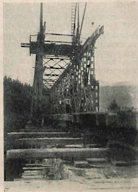
Fig. 2. Widok dwuścienny kratownicy w czasie montażu
