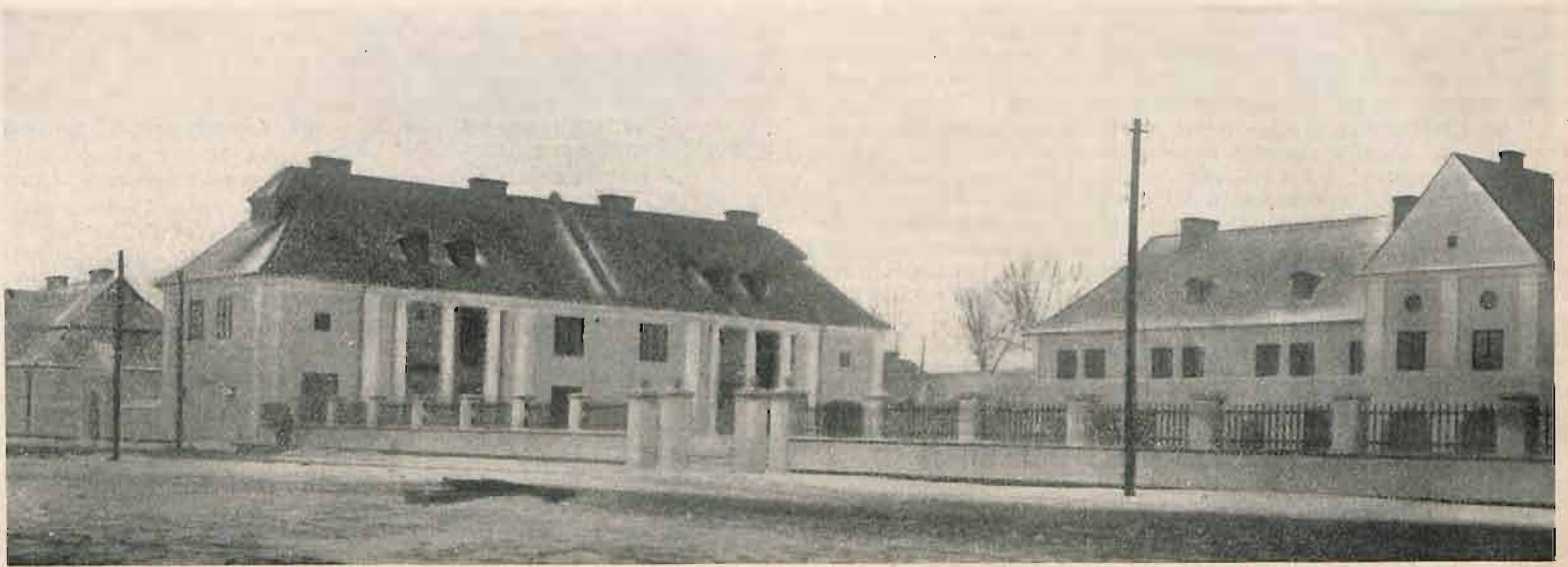
KOLONJA DOMÓW MIESZKALNYCH W KUTNIE. Dyrekcja K. P. Warszawa.
