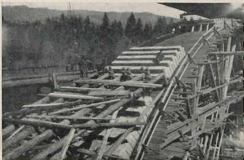
Rys. 12. Widok w czasie układania ciosów I pierścienia.
