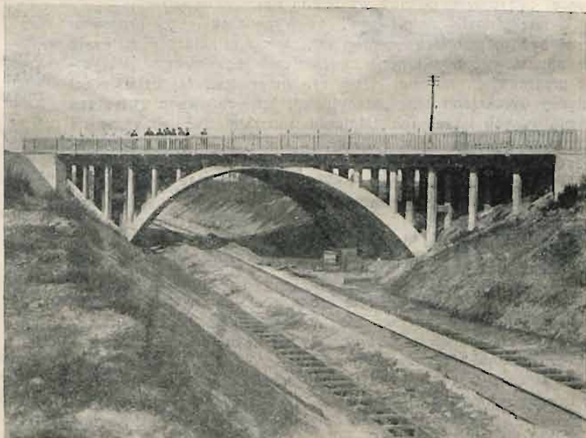
Wiadukt żelbetowy ukośny na szosie Łeczyca-Krośniewice (linja Zgierz-Kutno).
