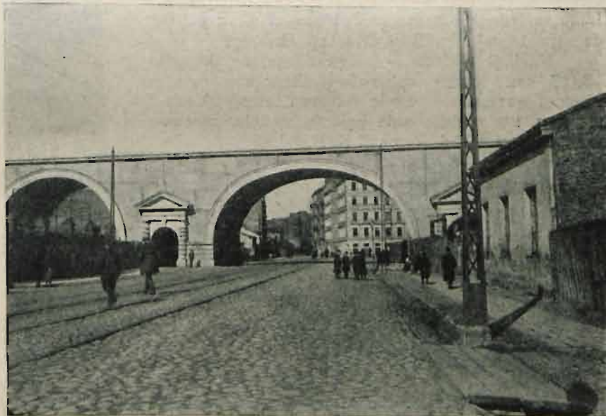
Przejście ul. Solec pod wiaduktem dł. 380 m. na Powisłu (linja średnicowa węzła warszawskiego).
