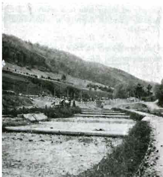
Rys. 15. Budowa zapory i korekcji progowej na potoku Łukowica (dorz. Dunajca).
