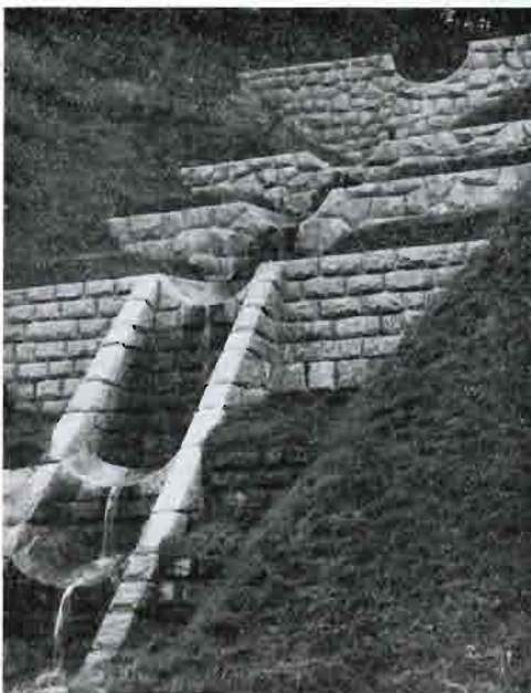
Rys. 12. Zabudowa jednego z potoków w obrębie zbiornika w Porąbce.
