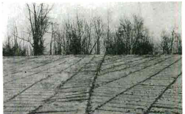
Rys. 2. Układanie elementów betonowych okładziny na lukach.
