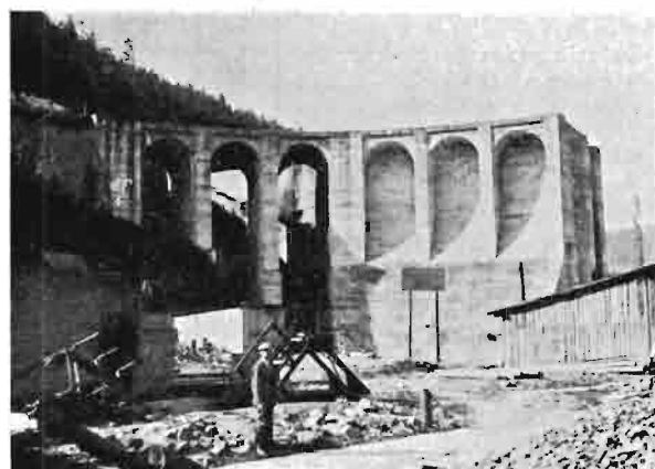
Rys. 5. Porąbka. Prawy przyczółek zapory.
