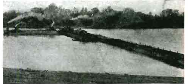
Rys. 1. Opuszczanie okładziny betonowej z barki o 700 m. od brzegu. Barki zakotwiczone umożliwiają barce posuwanie się wpoprzek rzeki.
