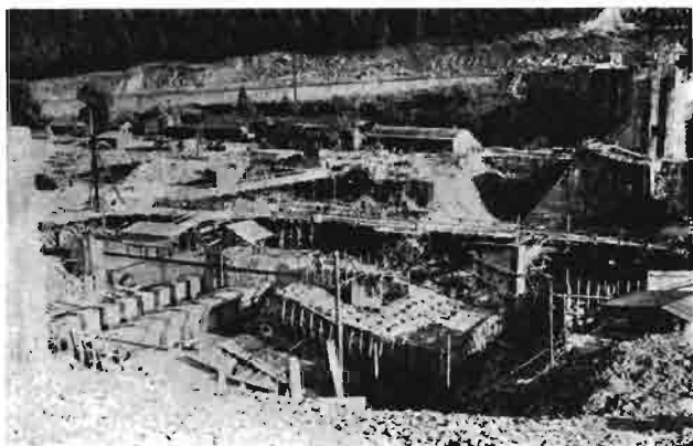
Rys. 2. Porąbka. Ogólny widok budowy w paźdz. 1935 r.
