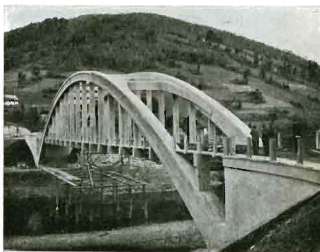
Rys. 9. Most żelbetowy, łukowy w Tresnie o rozpiętości 76 m, wybudowany przez Kierownictwo Budowy Zapory w Porąbce sposobem gospodarczym.
