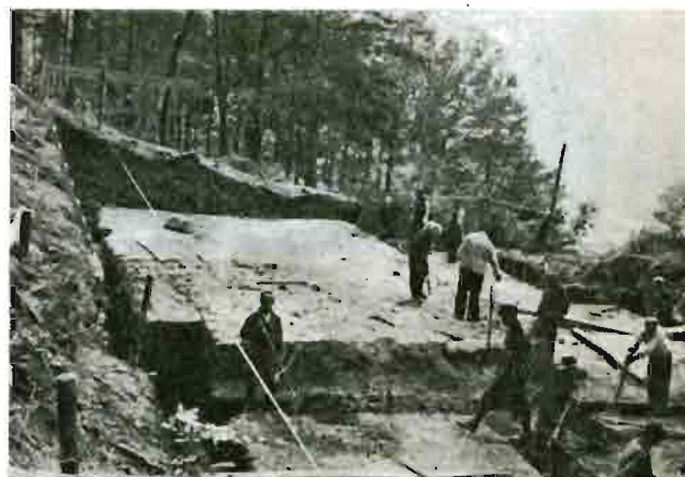
Rys. 10. Rożnów. Roboty ziemne. Wykop pod zaporę.
