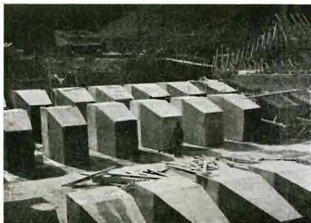
Rys. 7. Porąbka. Szykany dla niszczenia energii wody, spadającej z przelewów.
