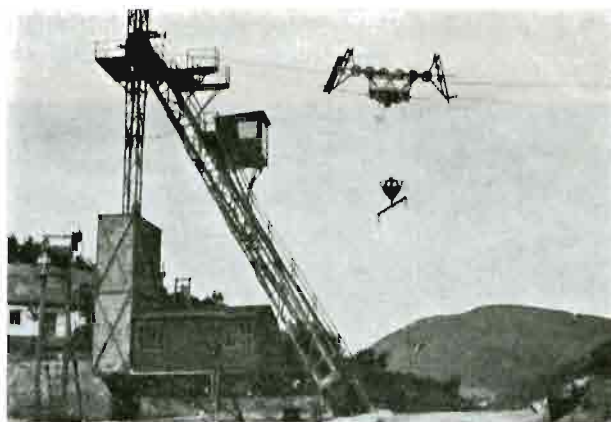
Rys. 8. Porąbka. Fragment kolejki linowej dla transportu betonu.
