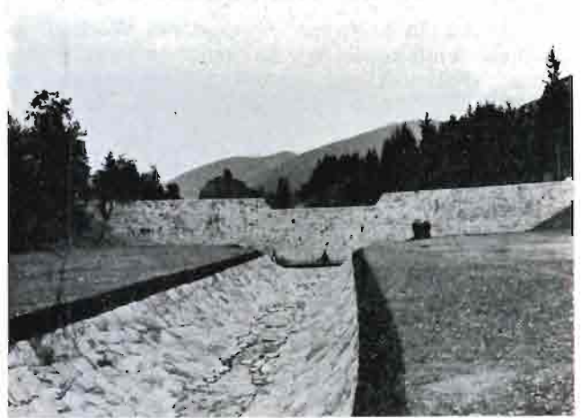
Rys. 13. Zabudowa potoku Isepnica, dopływu Soli.
