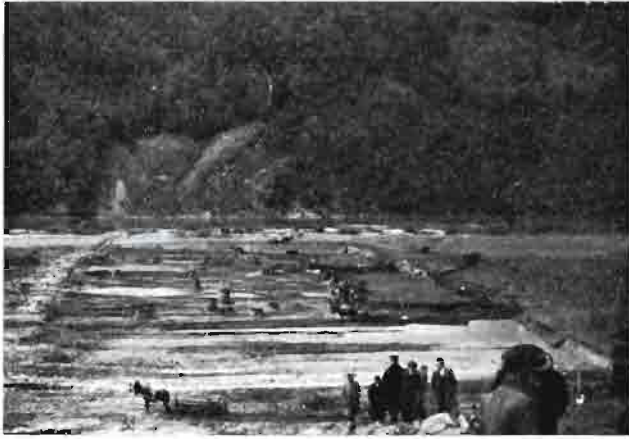
Rys. 11. Rożnów. Roboty ziemne.
