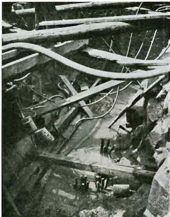
Rys. 6. Porąbka. Zastrzyki cementowe dla uszczelnienia skały.
