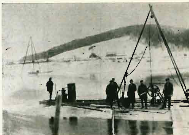
Ryc. 8. Wiercenie obrotowe w nurcie Dunajca.
