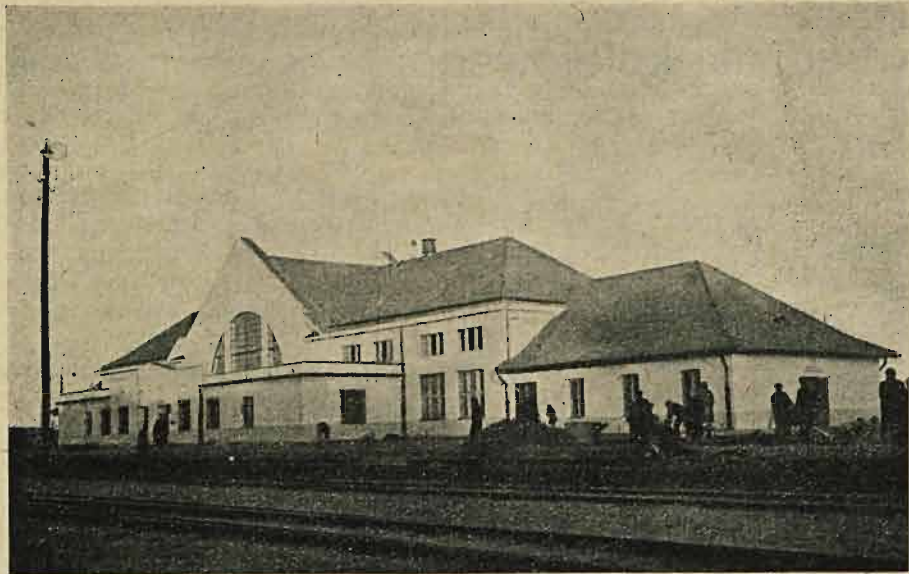
NOWY DWORZEC NA St. STOŁPCE.
