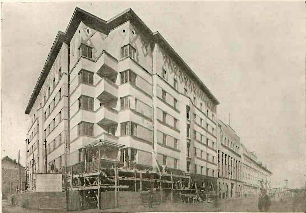
RYC. 12. ARCH. WACŁAW NOWAKOWSKI. DOM ZAKŁADU UBEZPIECZEŃ PRACOWNIKÓW UMYŚLOWYCH W KRAKOWIE, ULICA SIENKIEWICZA I WYBICKIEGO.
